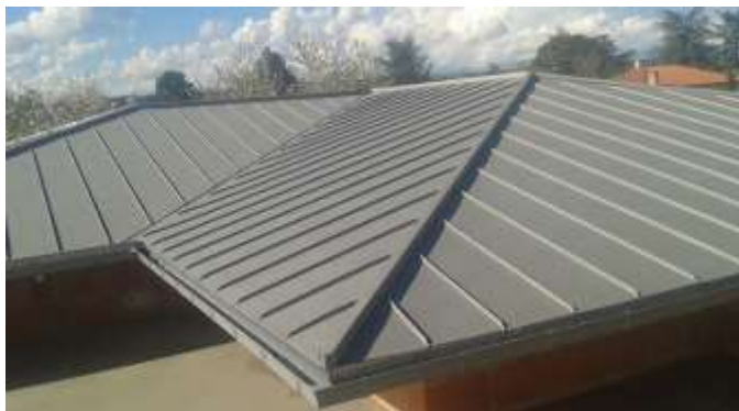
Illustration : toiture métallique à joints debout
