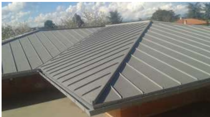
Illustration : toiture métallique à joints debout
